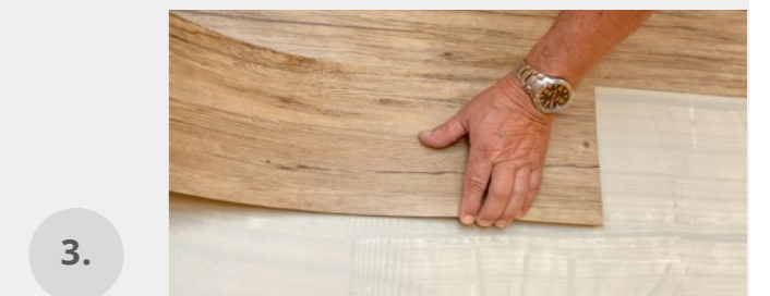
Pokládka vinylových dílců / laying vinyl tiles / Verlegung von Vinylteilen / Укладка деталей из винила / Pose de dalles vinyles
